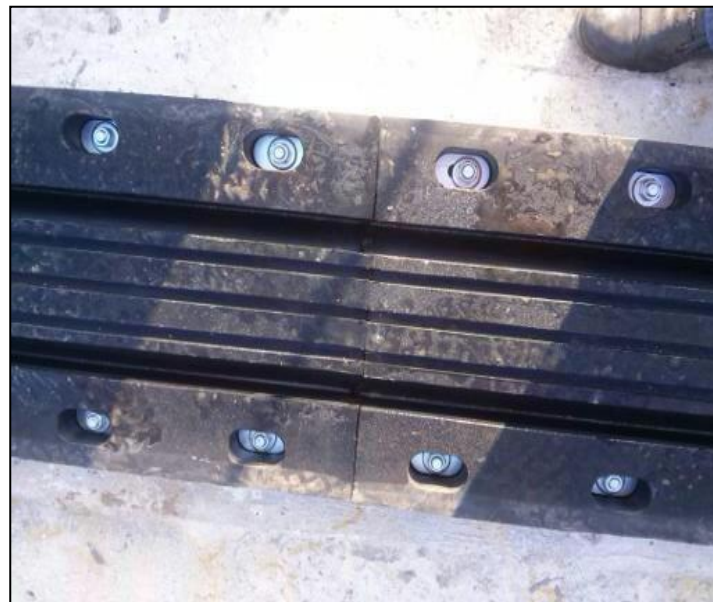
Figure 7 - Ajuste do conjunto de Chumbadores
