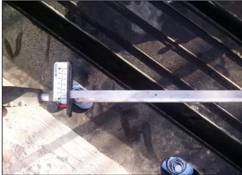
Figure 8 - Ajuste por Torquímetro
