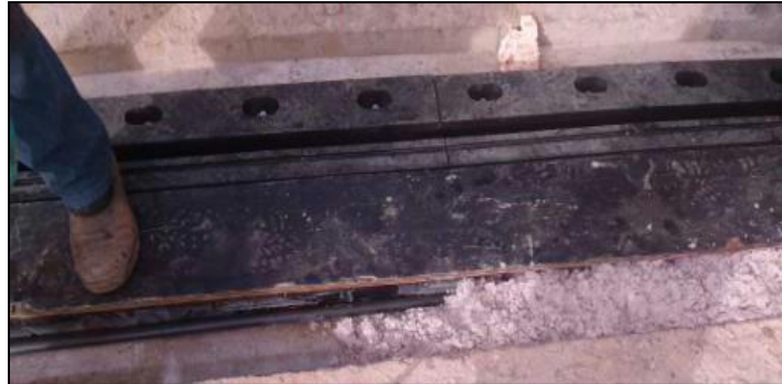
Figure 10 - Aplicação de Lábio Polimérico
