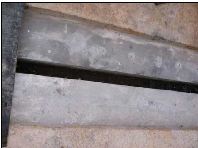
Figure 4 - Preparação de Leito para instalação
