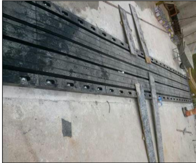
Figure 14 - Junta NP 260 sendo Instalada
