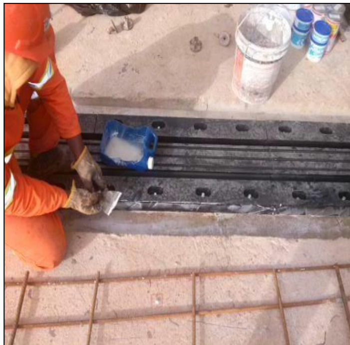
Figure 9 - Preparação do Leito para Instalação de Lábio Polimérico
