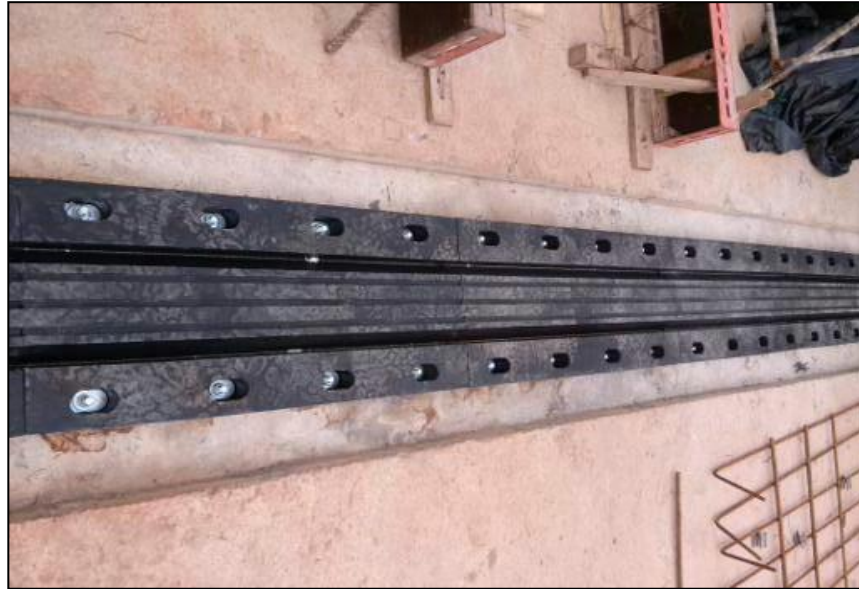
Figure 6 - Assentamento da Junta
